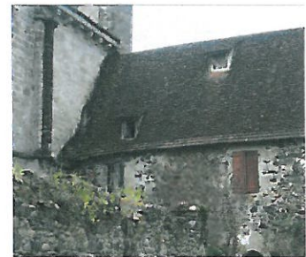
Deux exemples de couverture en tuile plate ancienne, d'épaisseur et pureau irréguliers, à noter :
