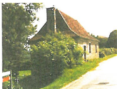
Dans le hameau de Sioniac, la tuile plate est dominante. Il n'y a pas d'édifices couverts en ardoises (en dehors de l'église). A noter le sogan qui amorti l'égoût de la toiture.
