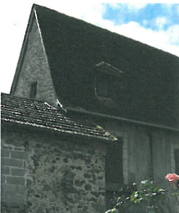
Les rives de pignon sont, de manière générale, peu débordantes. La rive est maçonnée, il n'y a pas de tuiles à rabat.
