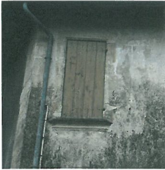
Rare exemple d'enduit conservant un décor de faux appareil de pierre. Les encadrements des baies étaient soulignés d'ocre rouge.
