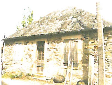
Cette maison du Battut aocation, ainsi que l'attestent les encadrements saillants à recevoir un enduit.
