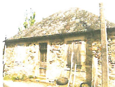
Au Battut, la tuile plate réside les couvertures en ardoises, matériau qui dénoie au cours du XIX e siècle.
