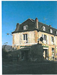
Toiture à combles brisés couverte en ardoise rectangulaire.
