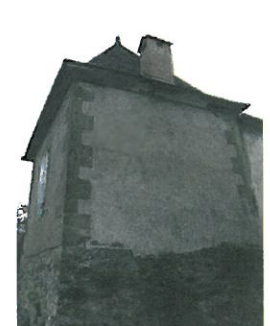
Ici, l'enduit est arrêté par une chaîne d'angle saillante et harpée de façon régulière.
