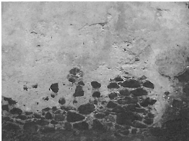
Exemple d'enduit à la chaux, finition lissée. L'érosion de l'épiderme permet d'observer la composition du mortier et l'utilisation d'un sable coloré de moyenne à forte granulométrie.
