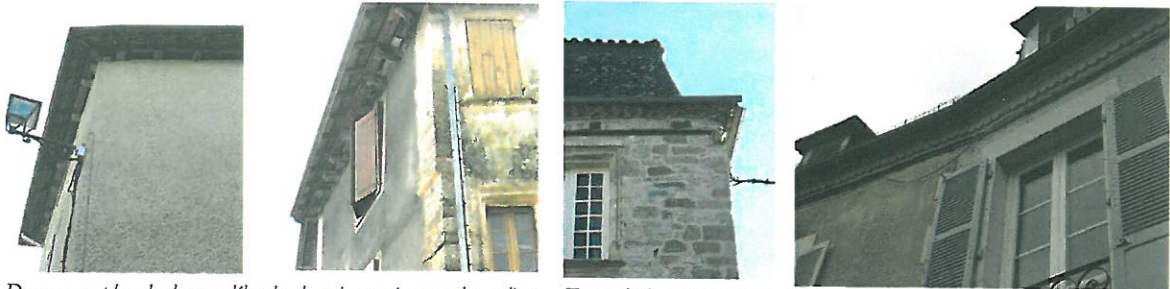
Exemple de génoise double, et d'une « variante » constituée de petits cylindres de terre cuite.
