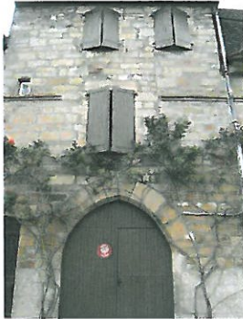
Maison présentant une maçonnerie dite appareillée ou assisée pouvant demeurer apparente. Lors d'éventuelles opérations de rejointoiement, la finesse des joints devra être conservée et la pierre ne devra pas être épaufrée (cassée) afin d'élargir les joints.
