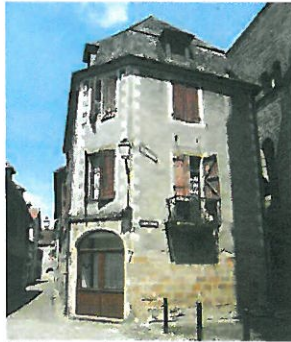
Maison présentant un enduit de ciment gris rehaussé d'un décor d'encadrement et de faux harpage blancs.
