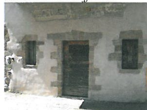
Exemple d'enduit fin détournant de façon rectiligne sans surépaisseur une baie à encadrement affleurant
