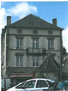
Toiture à quatre versants, de pente moyenne couverte en écaille d'ardoise.
