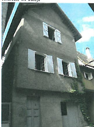
Deux exemples de rives largement débordantes portées par des abouts de pannes. Il s'agit de dispositifs mis en place dans le courant du XX e siècle qui dérogent aux principes traditionnels.
