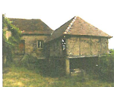
Sur cette maison située au Battut de caractère rural, un rejointoiement dit « à pierre vue » imitant les enduits anciens érodés pourra être mis en œuvre.
