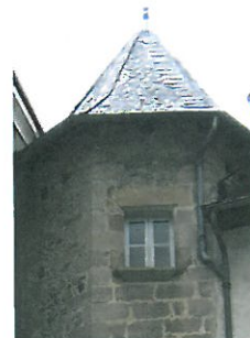
Exemple de couverture ancienne en écaille d'ardoise et lignolet
