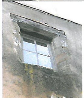
Exemple d'enduit fin détournant de façon rectiligne sans surépaisseur une baie à encadrement affleurant
