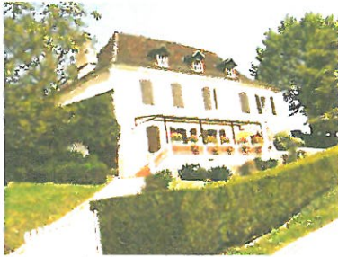
Les exemples de lucarnes sont relativement rares au Battut et à Sionnaz. Sur l'exemple ci-dessus situé au Battut, les lucarnes sont de charpente c'est-à-dire insérées dans le plan de la toiture et à joints rétro-versants.
