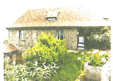
À Sionnaz, exemple d'un outeau placé assurant l'éclairage des combles.
