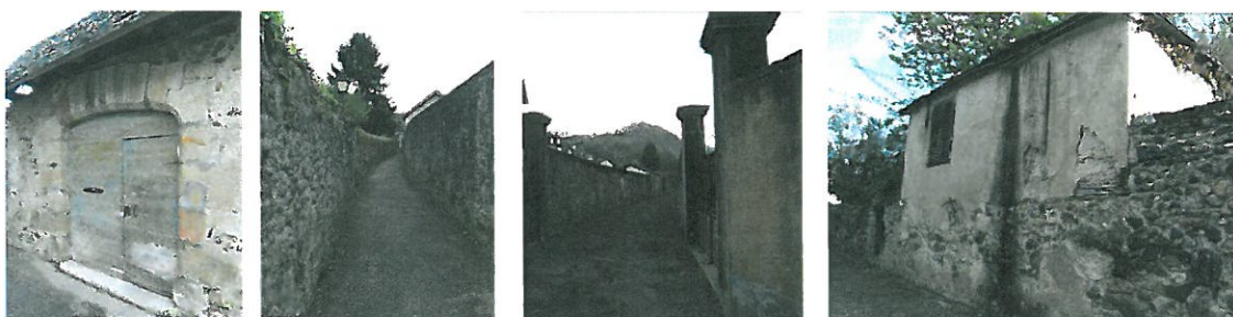
Les murs de clôture qui protègent les jardins sont assez hauts, ils ne laissent pas passer le regard. Ils ouvrent par des portails parfois monumentaux
