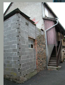
Extension en matériau laissé brut
