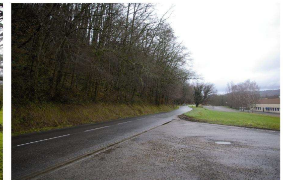
Front boisé : Depuis la route départementale RD 41 à proximité de la minoterie A gauche, le coteau est abrupt et boisé forçant le regard vers le vallée de la Dordogne.
