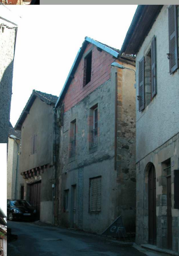
Surélévation en brique
